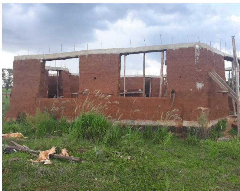
Figura 2 – Capela em Fase de Construção.
